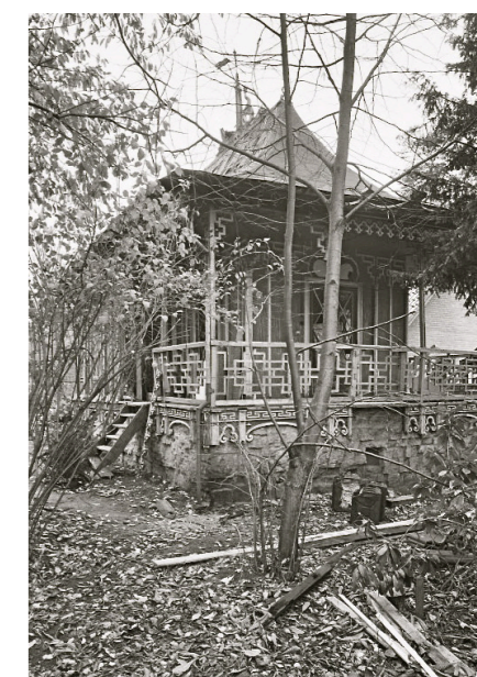
Foto 6: Theehuis tijdens de bouw in 1957 (bron: beeldbank RCE)
