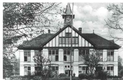
32. Het directiegebouw daterend uit 1912. Foto ca. 1920.
