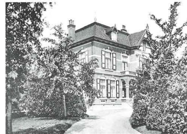
35. De Pleinesvilla, gesloopt in 1962 om plaats te maken voor de "Pelitaflat", die inmiddels ook al is afgebroken. Foto ca. 1910.
